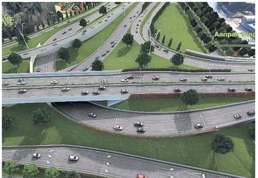
▲ Het omgebouwde Julianaplein. Afbeelding Projectbureau Aanpak Ringweg Groningen
